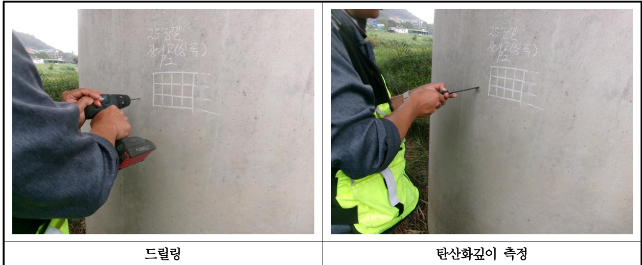
【사진 17.4.3】 탄산화 깊이 측정 현장사진
