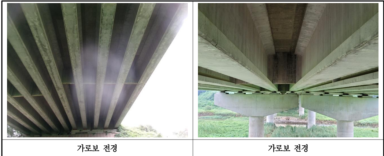
【사진 17.3.6】 가로보 전경
