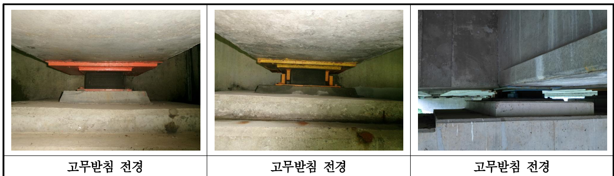
【사진 17.3.38】 교량반침 전경
