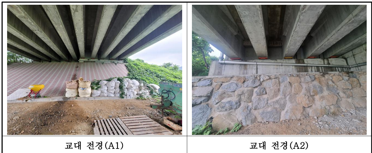
【사진 17.3.8】 교대 전경
