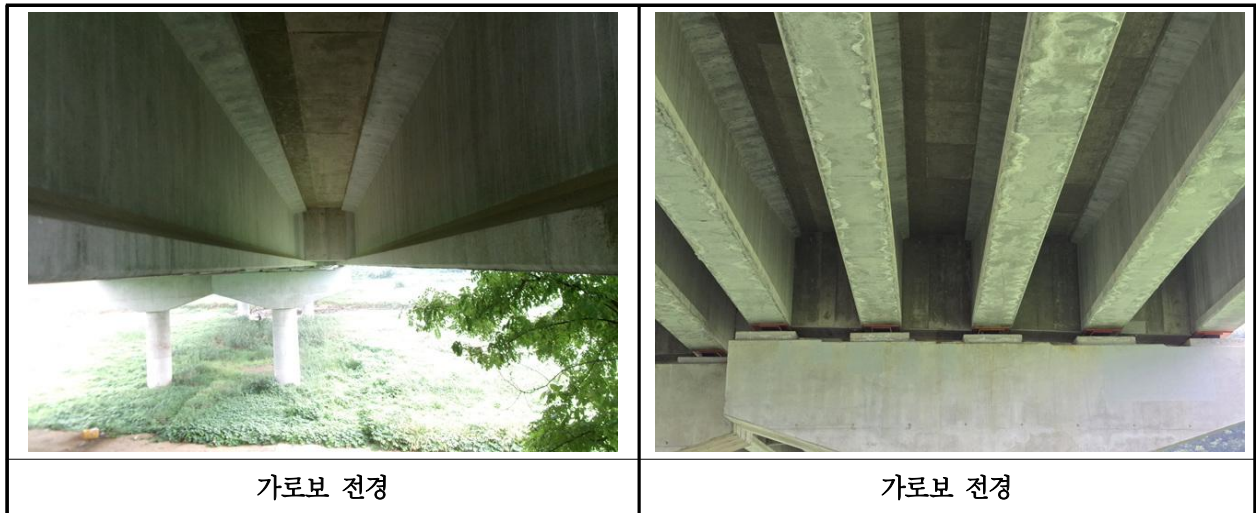
【사진 17.3.31】 가로보 전경
