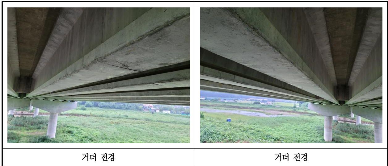
【사진 17.3.4】 거더 전경
