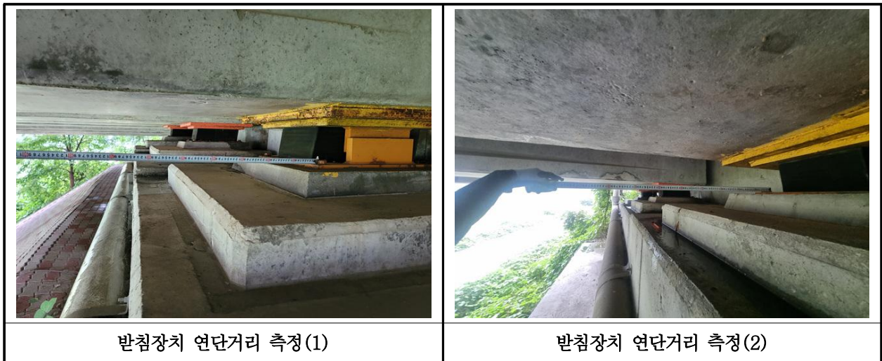
【사진 17.3.145교량받침장치 연단거리측정
