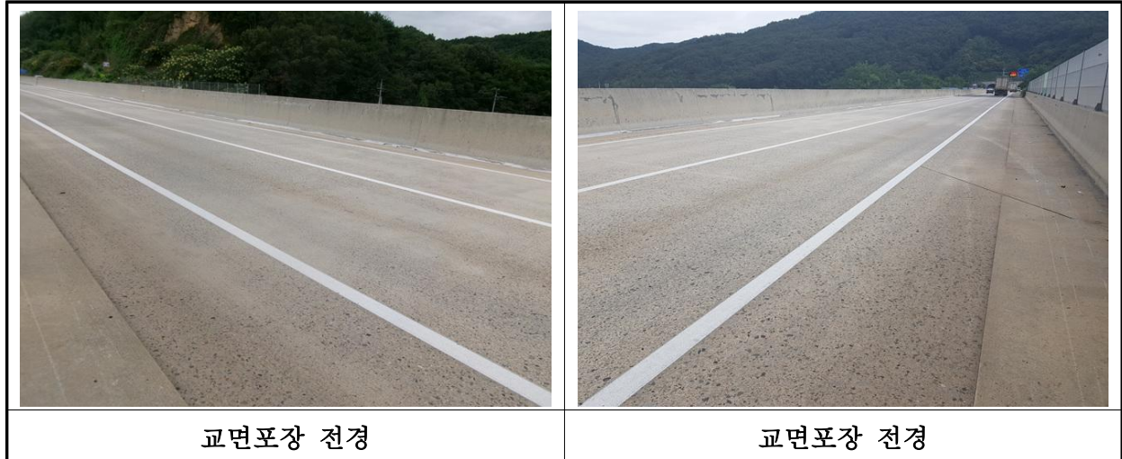
【사진 17.3.20】 교면포장 전경
