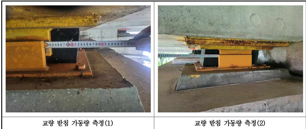
【사진 17.3.16】 교량받침 이동량 측정
