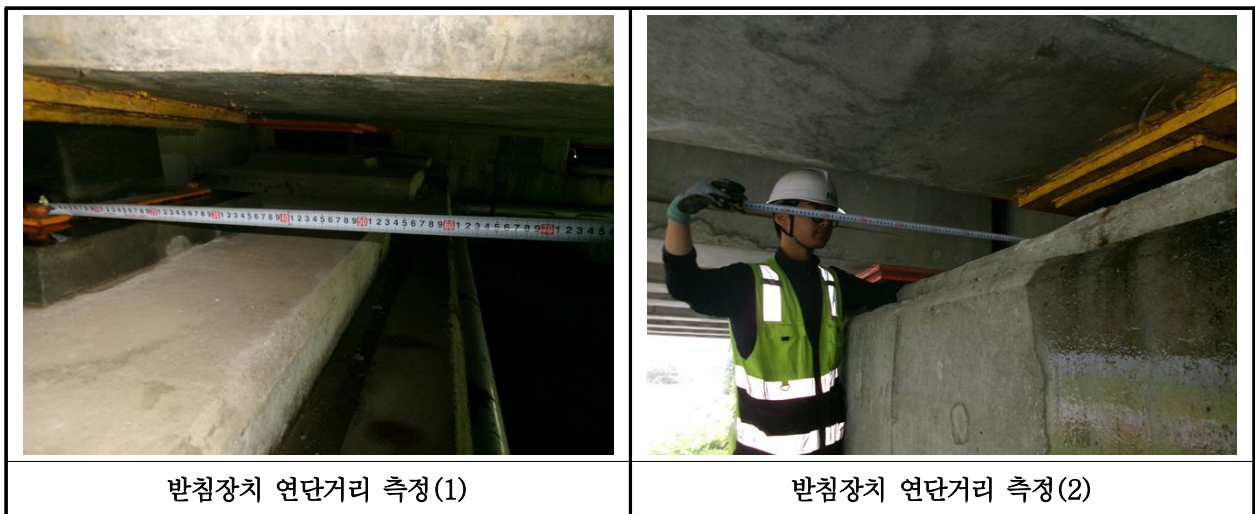
【사진 17.3.40】 교량받침장치 연단거리측정
