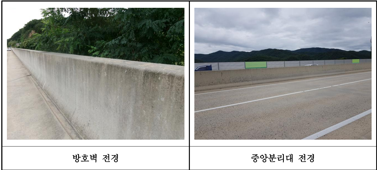
【사진 17.3.49】 방호벽 및 중양분리대 전경
