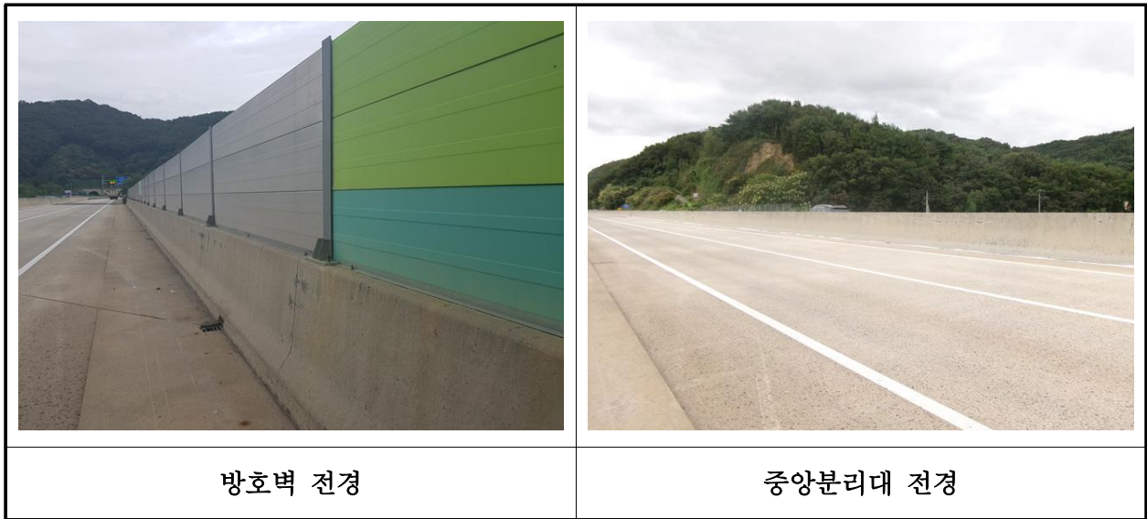
【사진 17.3.24】 방호벽 및 중앙분리대 전경
